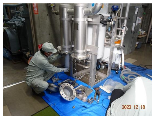
図 4.3 コアレッサフィルター交換作業の様子。
