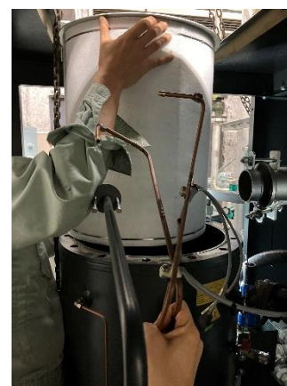
図 4.6 新しいオイルセパレーター。
