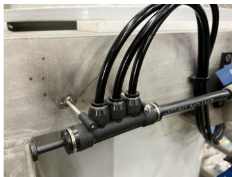
図 2. 1 計装空気配管。継手を新しいものに交換した。
