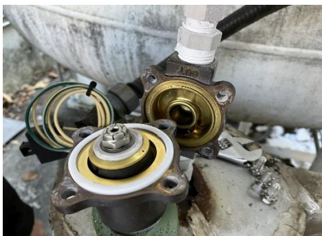
図 4. 2 電磁バルブのパーツ交換。左は交換のため分解したところ。右は新しく購入したパーツ。
