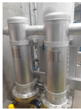
図3.3 コアレッサフィルター。筒状のフィルター。
