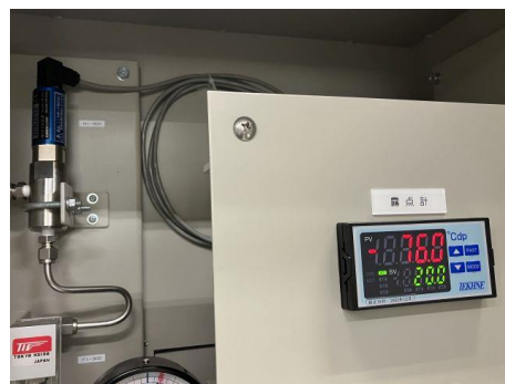
図 6. 1 露点計のセンサー部と表示部。正常な数値を示している。
