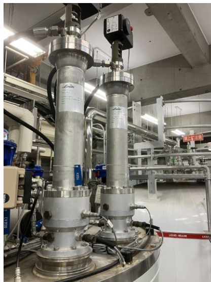
図2 コールドボックス上部に位置する第1および第2タービン部分の外観
