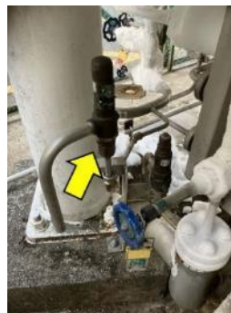
図4.1.5 矢印で示した安全弁を接続しているところが新しい配管。取り外しが容易になった。
