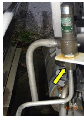
図4.1.1 工事前の配管。矢印は安全弁を取り付ける袋ナット。
