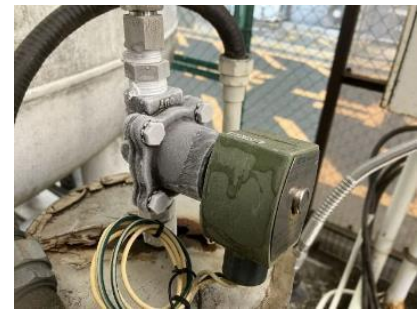
図 4. 3 電磁バルブ。液体窒素充填作業後で冷たい。
