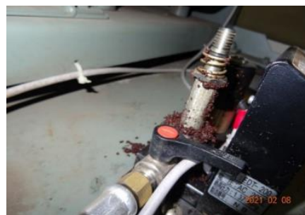
図 2.1 ベビコンのオートドレントラップのストレーナ。錆が見える。
