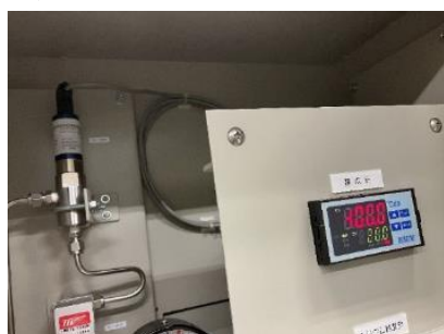
図 9.1 露点計のセンサー部と表示部。 -100^{\circ}\text{C} を表示しており、異常値である。
