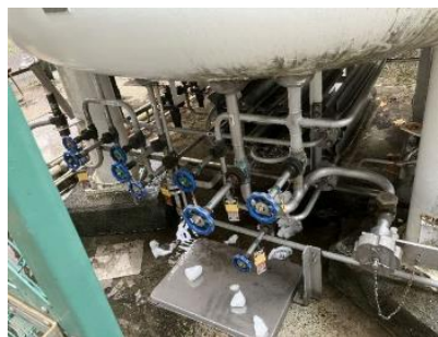
図 4. 5. 2 配管の霜を水で落とした。
