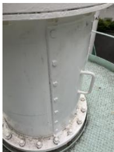
図 7.1 ガスホルダ上部の点検扉。
