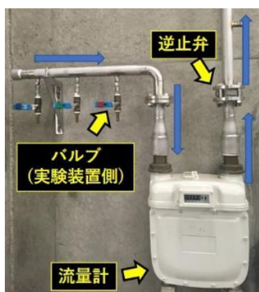
図 5. 2. 1 液化室の回収配管。装置から出たガスは、ボールバルブ、積算流量計、逆止弁の順に流れていく。
