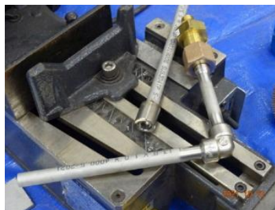
図4.1.3 新しい配管の取り付け前。現地で配管の加工を行った。
