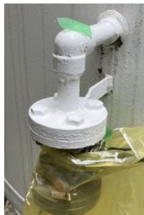
図 7.2.2 塗装した配管。
