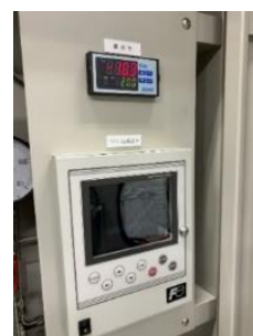
図 9.2 露点計の表示が正常化。ヘリウムガスの純度計モニターのバックライトは故障中。
