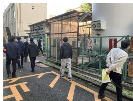
東京都による保安検査の様子
