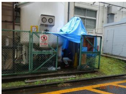
図4.1.4 工事の様子。ブルーシートで雨を防いでいる。溶接作業や気密検査等を行った。
