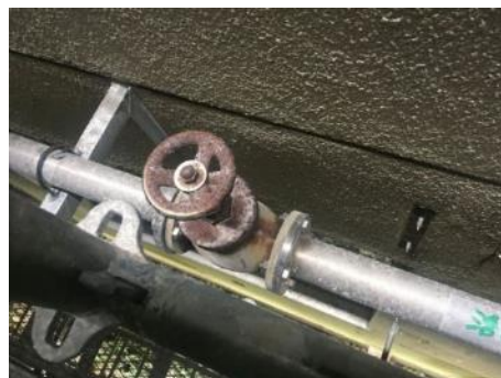
図 5.3. 工事中の壁面にある回収配管とバルブ。
