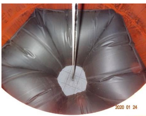
図3 ガスホルダー内部1。上部より撮影
