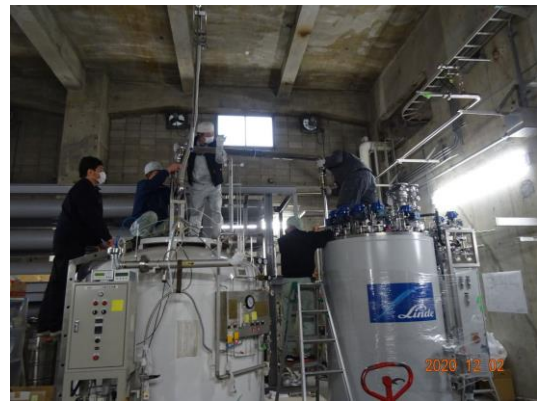
図2 すずかけ台液化室へ新しい液化装置を設置している様子。
