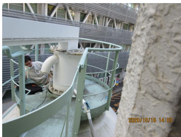
図5 センター技術職員による回収ガスホルダーの応急修理の様子。
